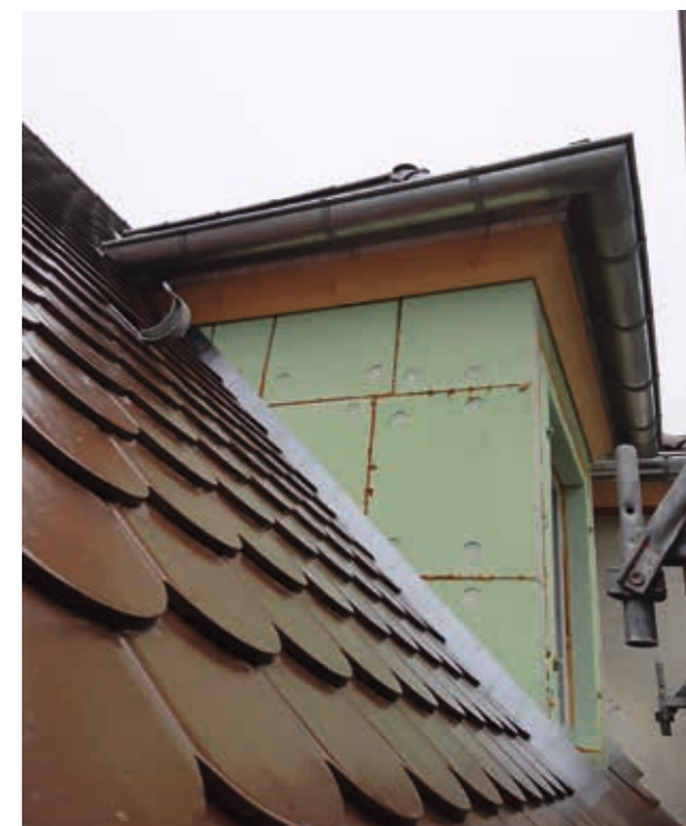
Dämmung einer Dachgaube im Aschantidorf
