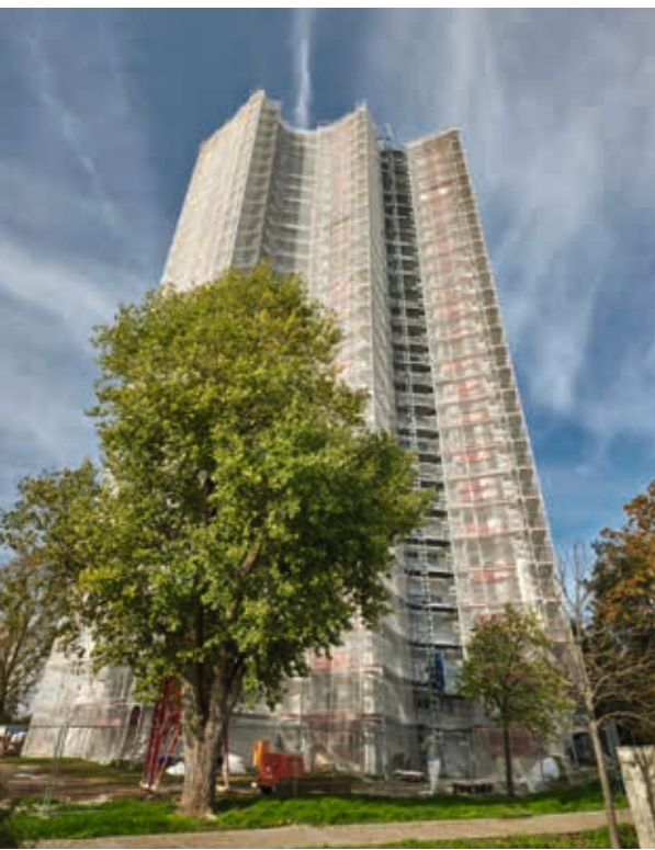
Eingerüstetes Hochhaus in Frankenthal
