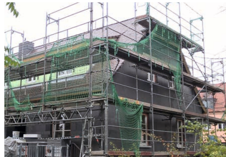
Dämmung einer Dachgaube im Aschantidorf
