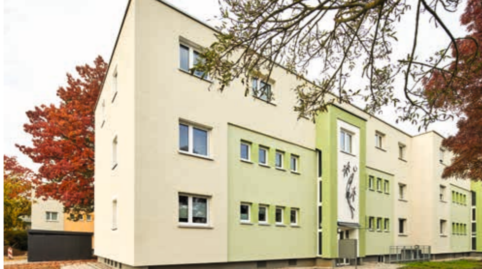
Fertiggestelltes Mehrfamilienhaus nach Sanierungsmaßnahmen im ehemaligen Jugenddorf Limburgerhof
